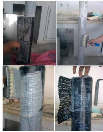
الشكل (6) مراحل التغليف بالألياف الكربونية عرضياً.
